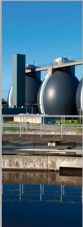
Evacuación del agua
