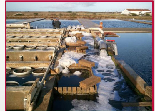
Bombas de circulación para el enriquecimiento de oxígeno en acuicultura, ostricultura, Francia
