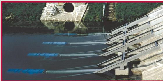
Bombas de drenaje para la protección contra inundaciones, Alemania
