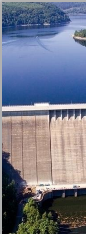
Bombeo de agua
