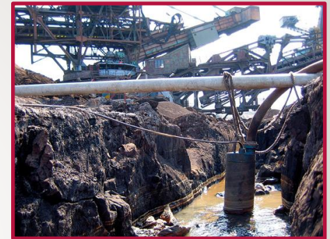
Bombas de desagüe para el drenaje de suelos de minas a cielo abierto, Alemania
